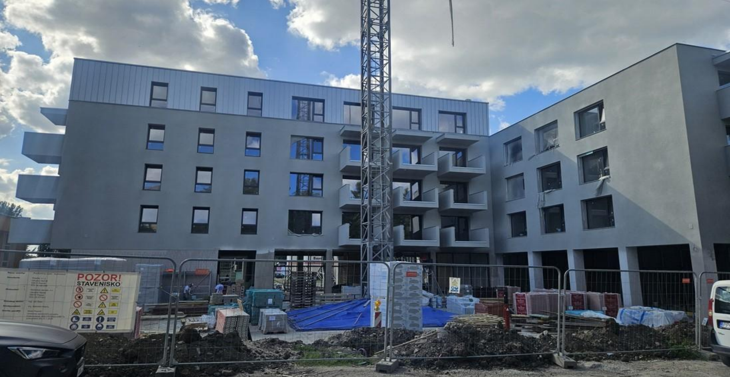
Utesnenie stropu nad podzemnými garážami X911
