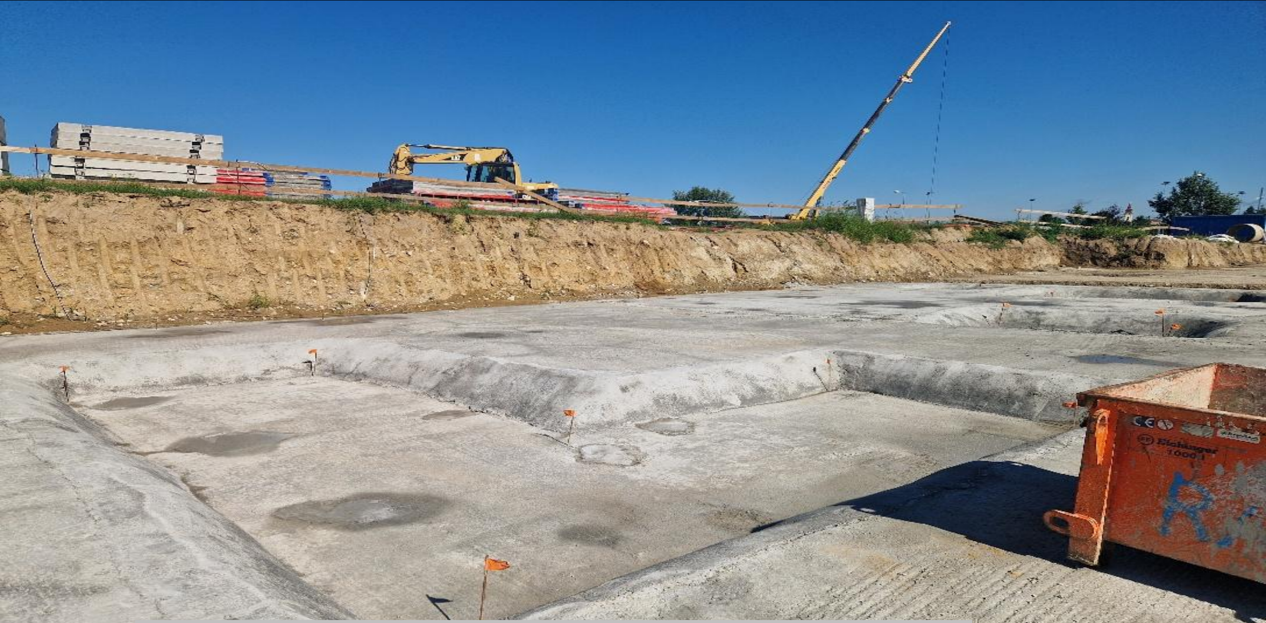
Zhotovenie podkladného betónu
